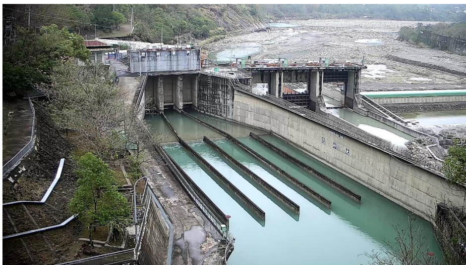
甲仙攔河堰引水相片
