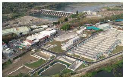
豐原前處理機電整備工程
