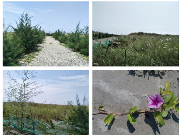
圖 8 濁水溪許厝寮堤段整建工程現場勘查照片
