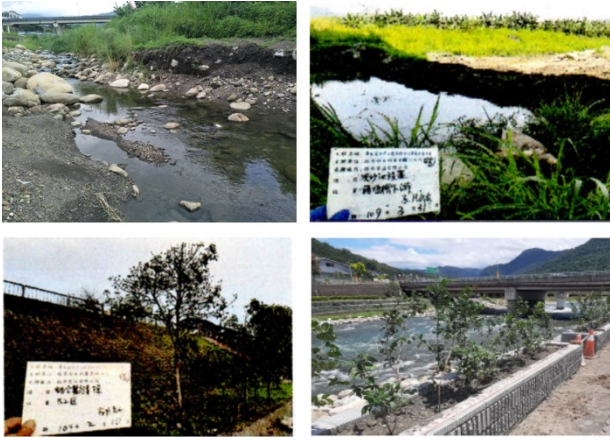
圖 13 濁水溪社子二號堤防生態友善措施執行紀錄 (左上：保留澤蟹棲地；右上：增設沉砂池；左下：移 除銀合歡；右下：新植綠帶)
